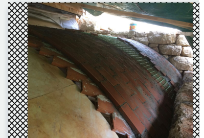
Voûte catalane réalisée à Sainte-Croix, 2017 : les briques de la voûte de fond sont posées en épis. D’une épaisseur totale de 12cm, elle est constituée de trois couches de briques.
