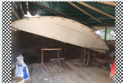
Voûte catalane réalisée à Sainte-Croix, 2017 : pour faciliter la réalisation, un coffrage glissant de 70 cm est employé. Les briques sont posées au plâtre puis le coffrage est déplacé après un temps de séchage.
