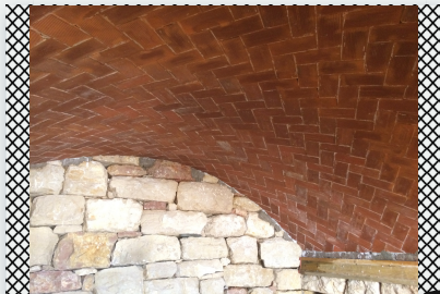
Voûte catalane réalisée à Sainte-Croix, 2017 : voûte en canon de parabole (une parabole glisse sur une droite) pour constituer une cave attenante d’un édifice.
